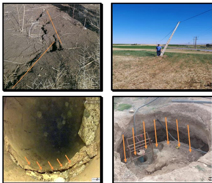
شکل ۹ الف) کج شدن تیر برق در روستای تازه‌آباد چراغ‌آباد؛ ب) تغییر محل شیب زمین و شکاف ایجادشده در زمین کشاورزی؛ ج) فرورانش در روستای شه‌بیه (امور آب استان؛ د) گسیختگی در جداره چاه روستای سراب
