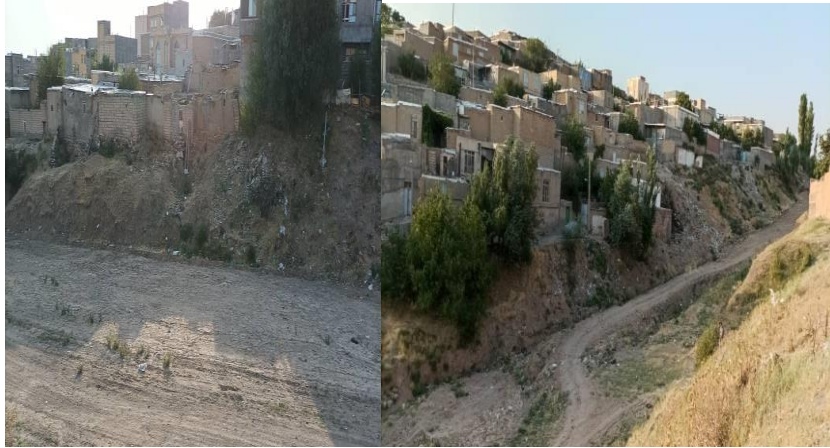
شکل ۵. تأثیر شیب و بریدگی‌های عمودی در زمین لغزش منطقه و کناره‌های جاده (نگارندگان)
