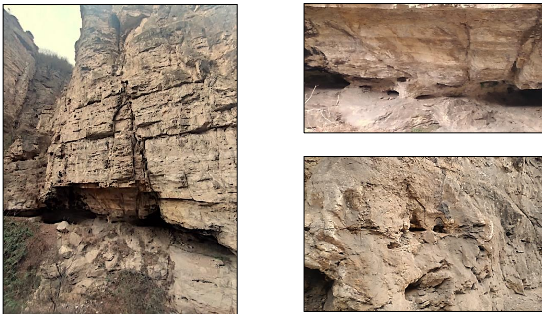
شکل ۷. ایجاد اشکال و غارهای انحلالی در امتداد لایه‌بندی سنگ آهک‌های سازند مبارک در منطقه هزارچم
